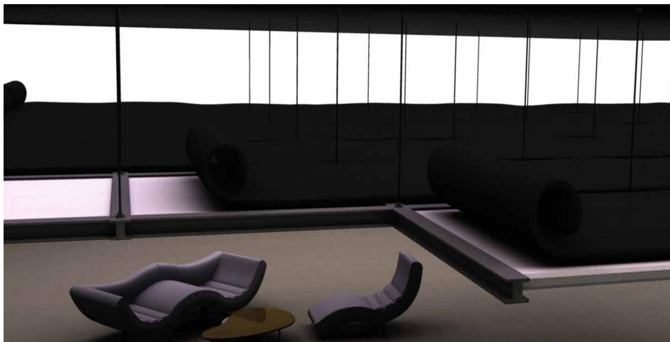
ESEMPIO DI ISOLAMENTO TERMOACUSTICO IN CONTROSOFFITTO CON PRODOTTO IMBUSTATO, AUTOESTINGUENTE E PRATICO DA POSARE
